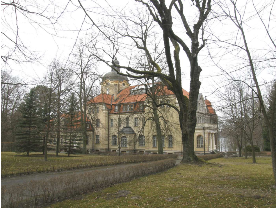
Ryc. 1. Pałac w Łęczanach – strona zachodnia, widok od jeziora i centralnej łąki (Fot. D. Kubiak).
